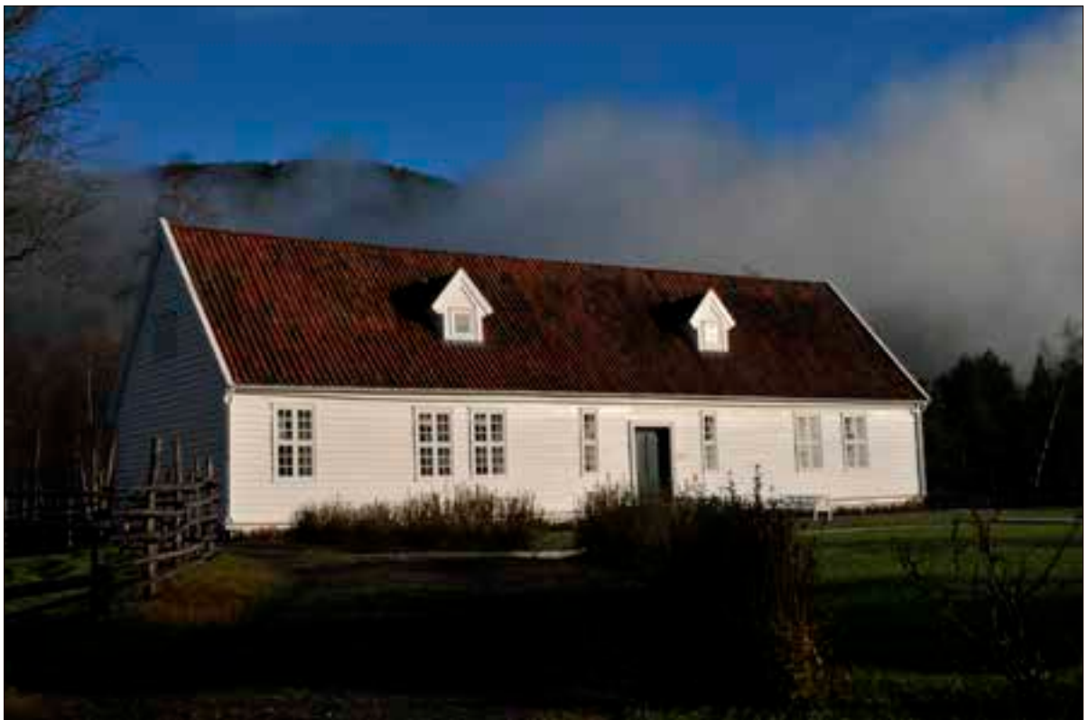
Den staselege prestegarden frå Vik frå 1760-talet, som vart flytta frå Amla til Vestreim i 2005, er ferdig restaurert utvendig. No held vi på å restaurere eine stova. Foto: DHS-SF/ MiSF
