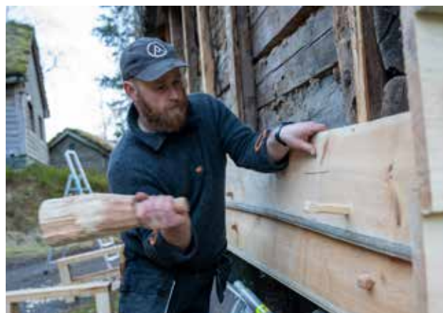
Handverkar Elling Hauge slår inn trepluggane som fester kledninga på Tystadstabburet.
